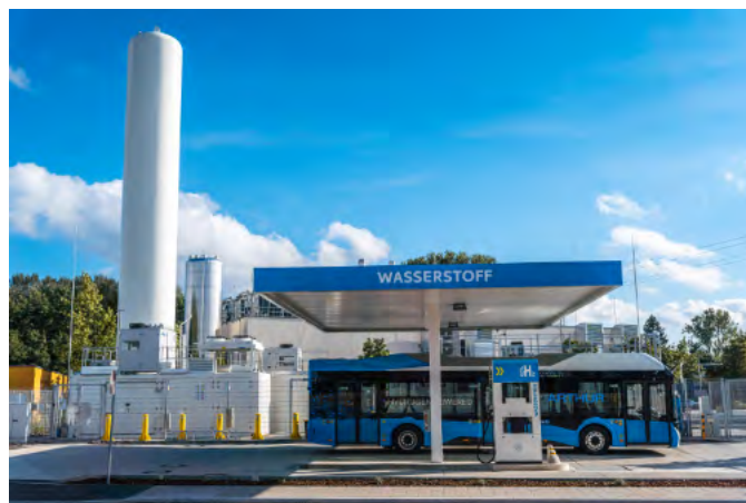
Zapfsäule zur Abgabe von Wasserstoff Foto H2 Mobility Deutschland GmbH & Co. KG
