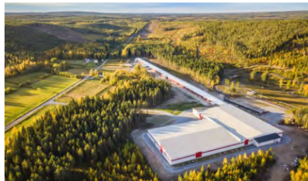
Prüfhalle von außen
